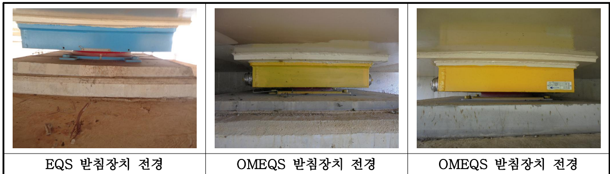
【사진 3.3.12】 교량받침 전경
