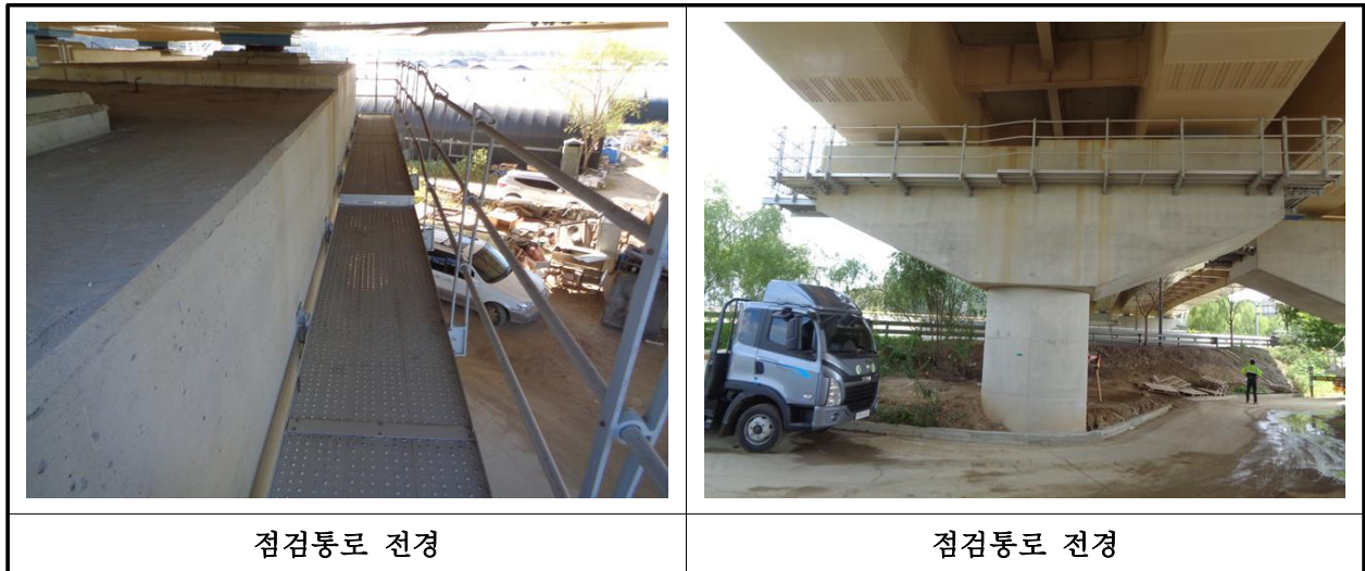
【사진 3.3.25】 교량 점검시설 전경
