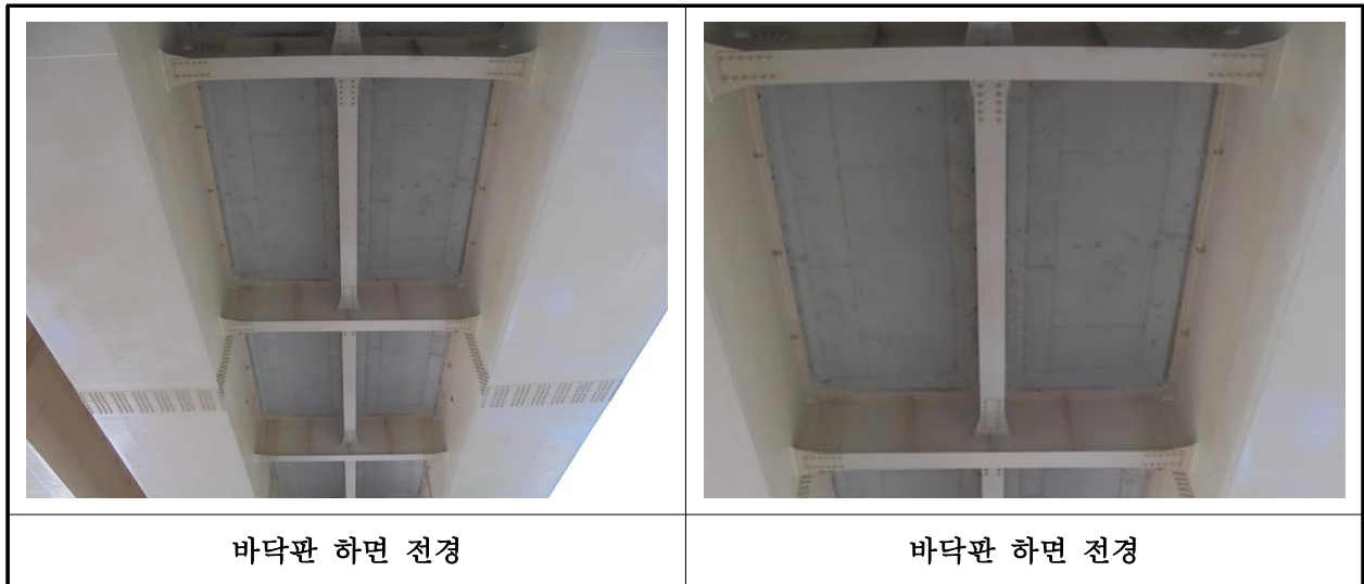
【사진 3.3.2】 바닥판하면 전경
