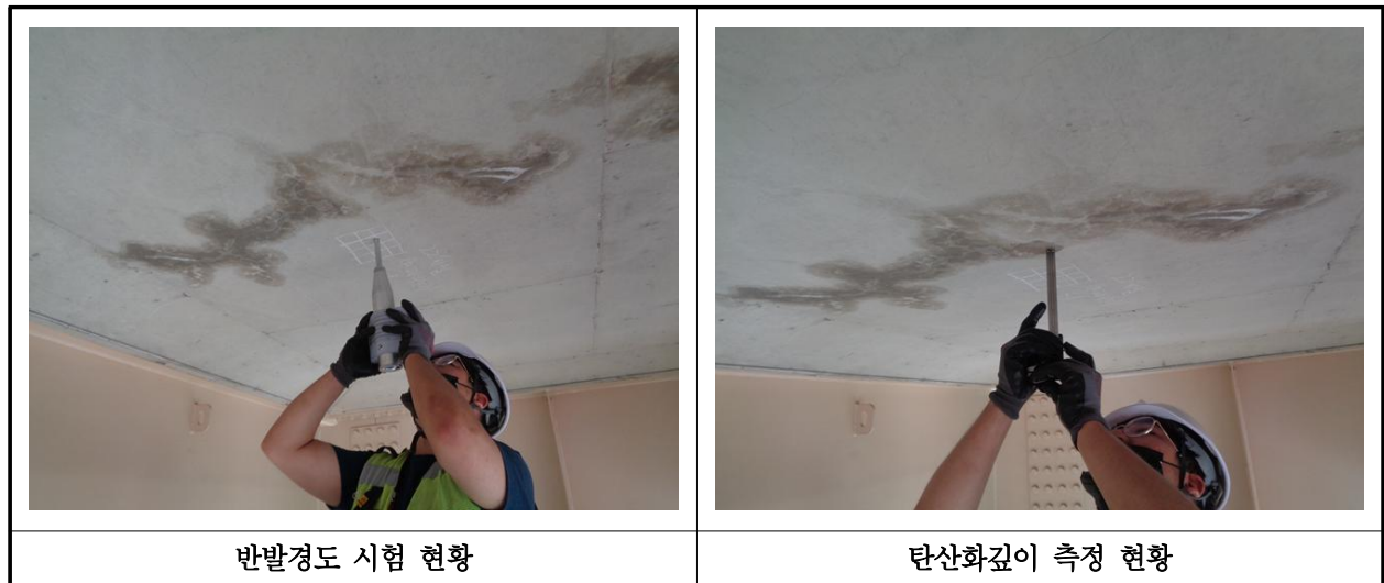
【사진 3.4.1】 콘크리트 내구성조사 현황
