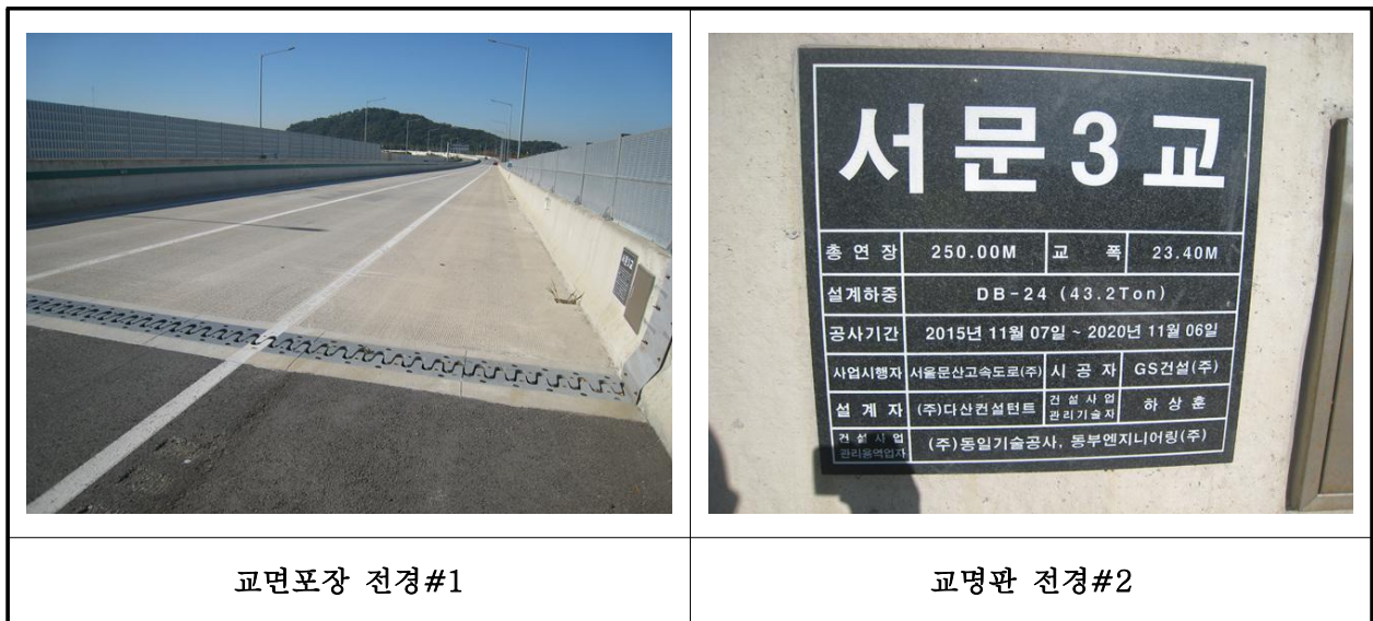
【사진 3.3.19】 교면포장 전경
