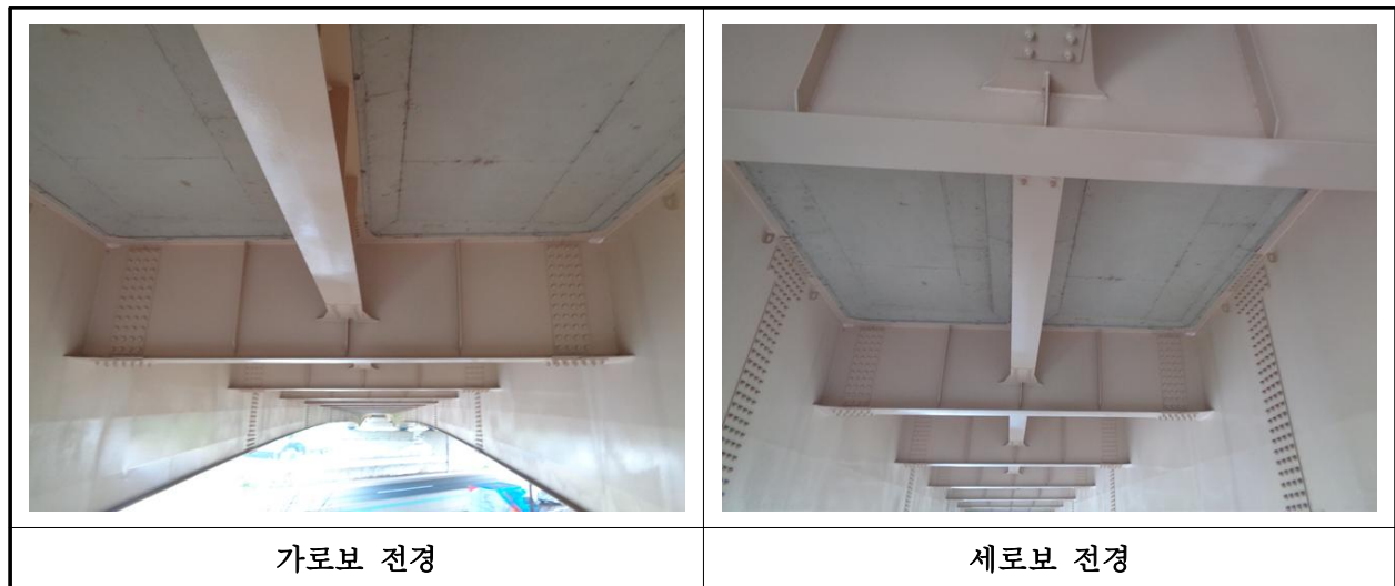
【사진 3.3.6】 가로보 및 세로보 전경
