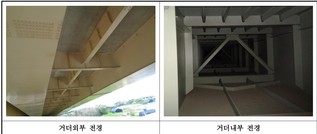
【사진 3.3.4】 거더 전경
