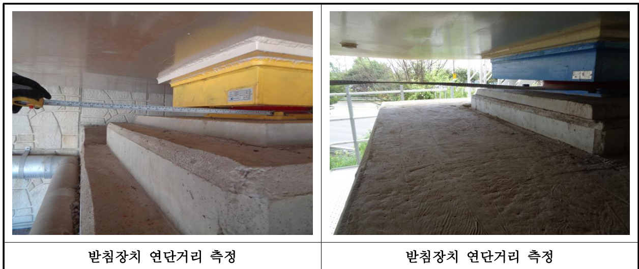
【사진 3.3.14】 교량받침장치 연단거리측정
